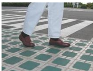
屋外通路の滑り止めシール
