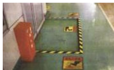
内扉の段差に注意喚起
