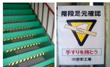
階段の滑り止めシールと注意喚起
