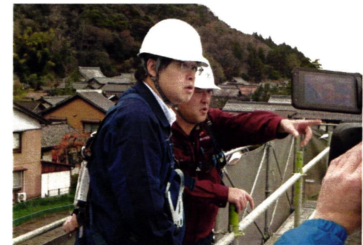
12月12日 ゼロ災55局長建設現場 パトロール（安全対策）
