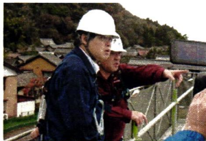
ゼロ災55局長建設現場 パトロールこおげ建設 株式会社施工現場 12/12
