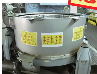
機械設備に貼られた注意事項
