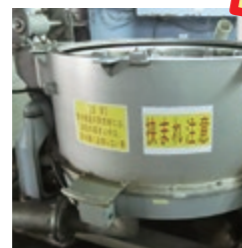
機械設備に貼られた注意事項
