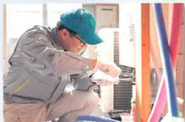
水道(給排水設備)
