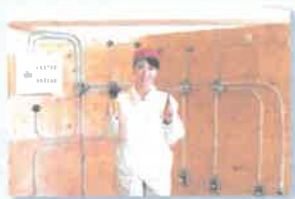
現場を想定した配線工事
