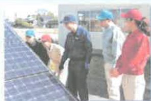
太陽光パネルなどの設備工事
