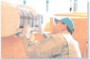
エアコン(空調設備)工事
