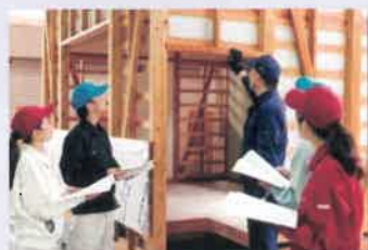
木造住宅の外装内装工事
