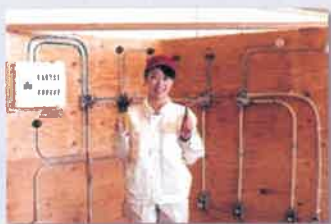
現場を想定した配線工事
