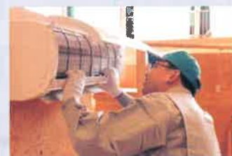
エアコン(空調設備)工事
