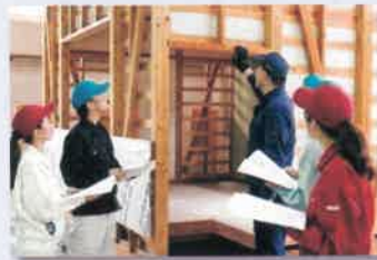
木造住宅の外装内装工事
