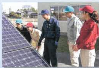
太陽光パネルなどの設備工事
