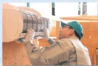
エアコン(空調設備)工事
