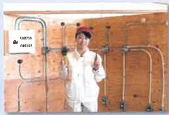
現場を想定した配線工事
