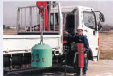
クレーン・玉掛け作業
