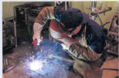
被覆アーク溶接
