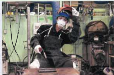
ガス溶接・炭酸ガスアーク溶接
