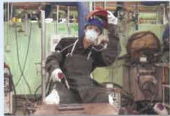
ガス溶接・炭酸ガスアーク溶接
