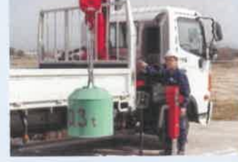
クレーン・玉掛け作業
