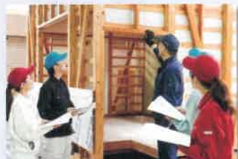
木造住宅の外装内装工事
