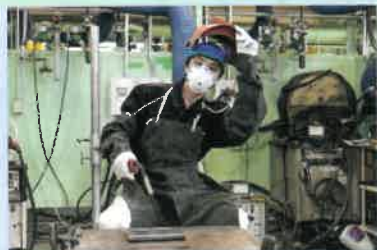
ガス溶接・炭酸ガスアーク溶接
