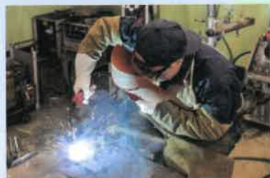
被覆アーク溶接
