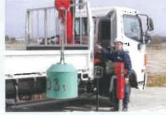
クレーン・玉掛け作業
