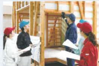
木造住宅の外装内装工事
