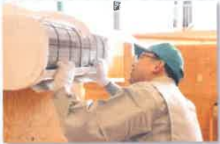
エアコン(空調設備)工事
