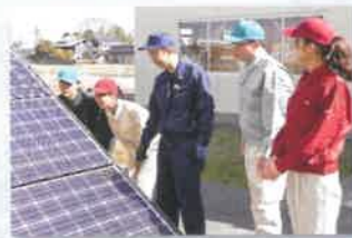
太陽光パネルなどの設備工事
