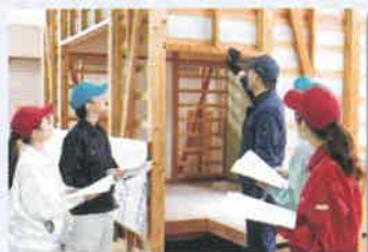
木造住宅の外装内装工事
