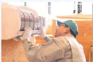
エアコン(空調設備)工事
