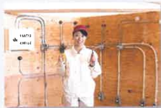
現場を想定した配線工事
