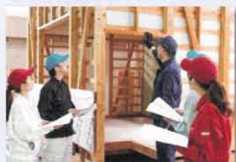
木造住宅の外装内装工事
