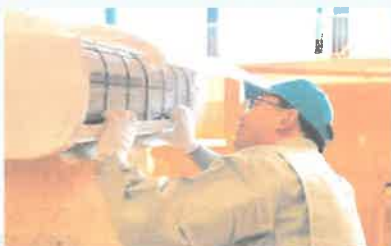
エアコン(空調設備)工事
