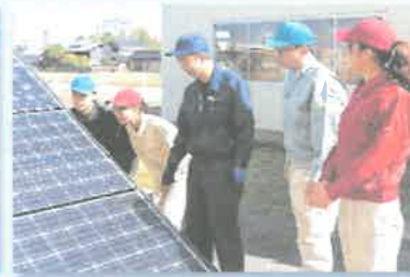
太陽光パネルなどの設備工事
