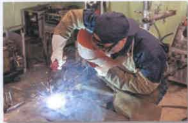
被覆アーク溶接
