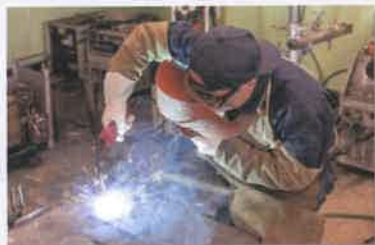
被覆アーク溶接
