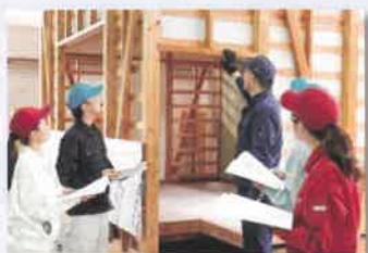
木造住宅の外装内装工事
