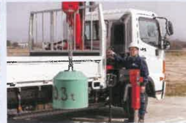
クレーン・玉掛け作業
