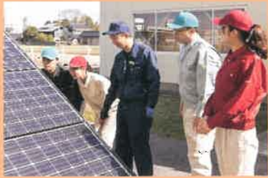
住宅電気設備
