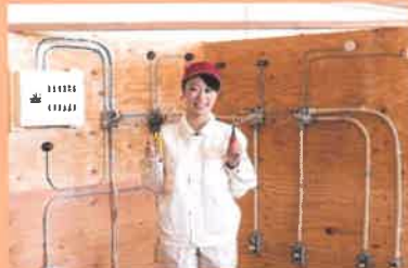
住宅電気配線
