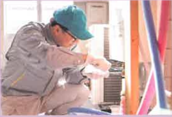
給排水衛生設備
