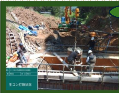
生コン打設状況
