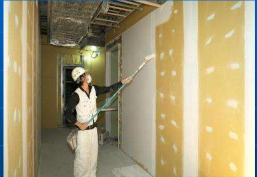
工場製品の取付や混ぜ合わせ済の材料の使用等により作業が簡素化しています
