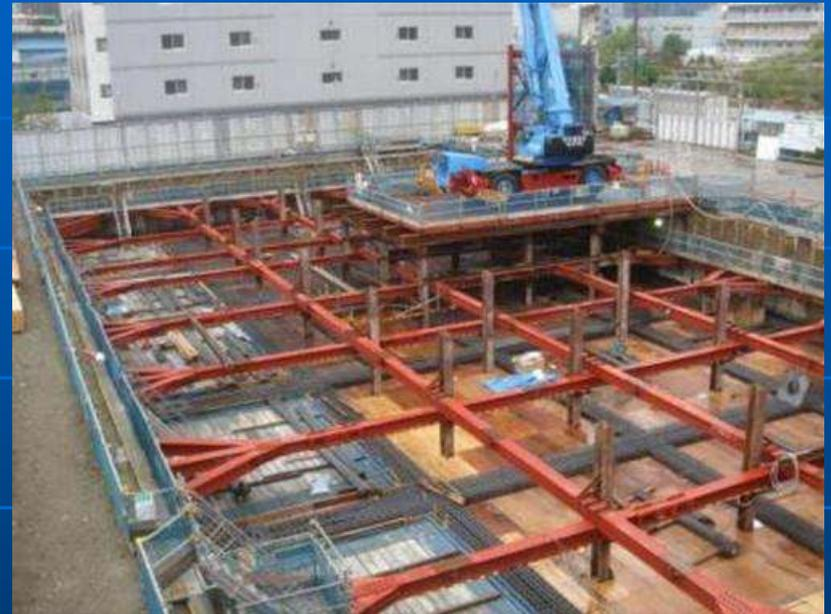
工場で作成した部材の取付等で危険な作業の減少や重機を利用する事により重い物の取付作業を低減しています
