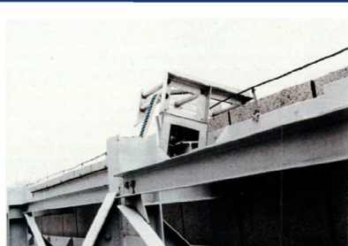
屋上パラペットの専用養生材を使用した安全な事例
