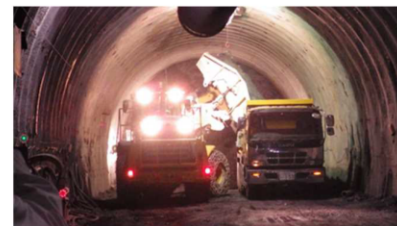
車両系機械によるずり出し作業
