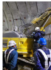
(3) 車両系機械を用いた測定
