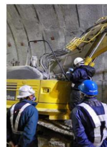
(3) 車両系機械を用いた測定
