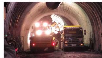
車両系機械によるずり出し作業
