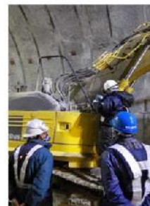
(3) 車両系機械を用いた測定
