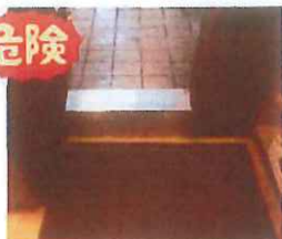
厨房とクーラー通路の境目
