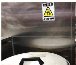
設置例① 炊飯器付近
