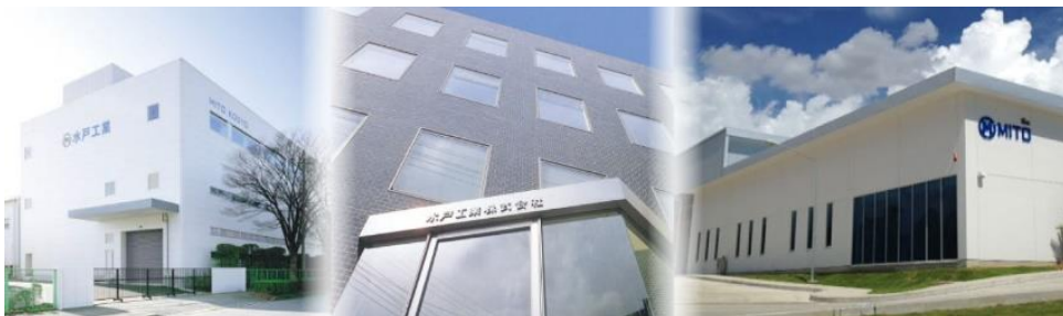
越谷補給センター
