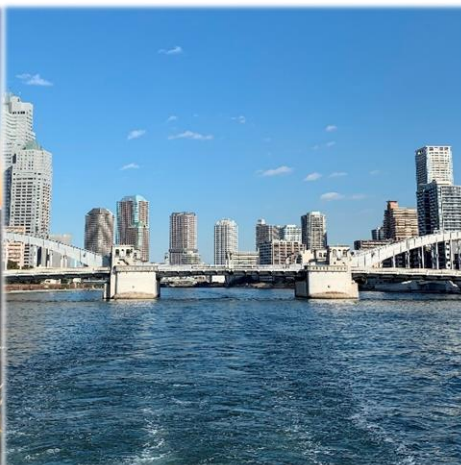
中央区(勝鬃橋)
