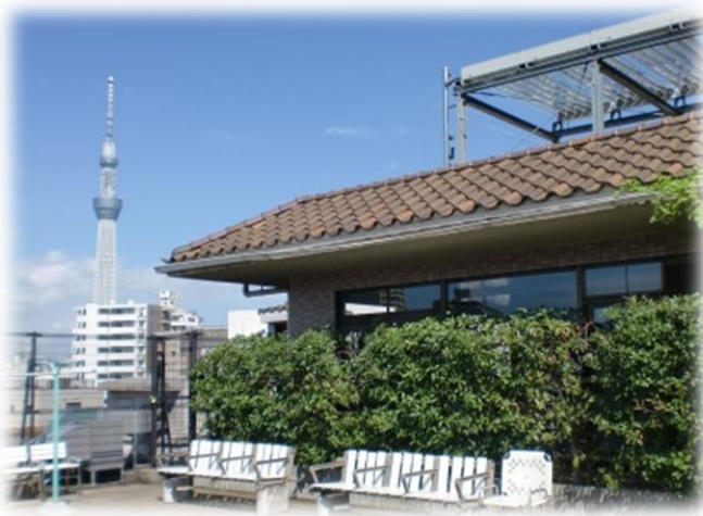
屋上からはスカイツリーがすぐ側に！
