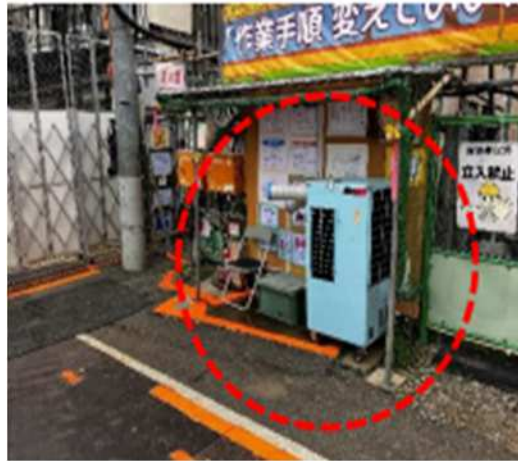
庇+送風機を設置
