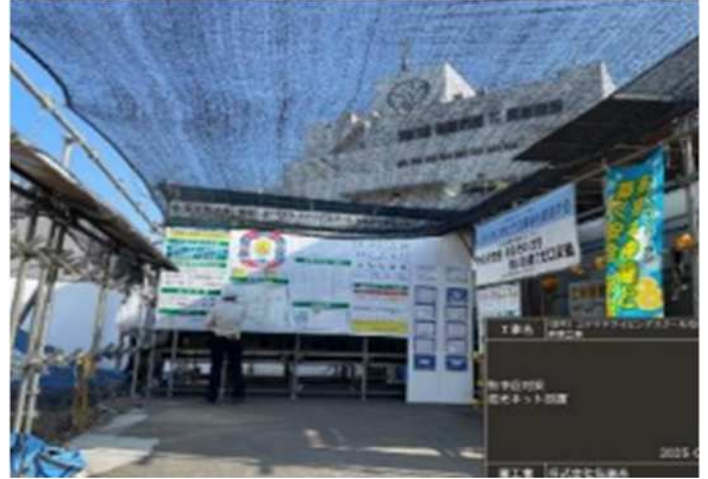
遮光ネットにより、朝礼箇所の日陰を確保
