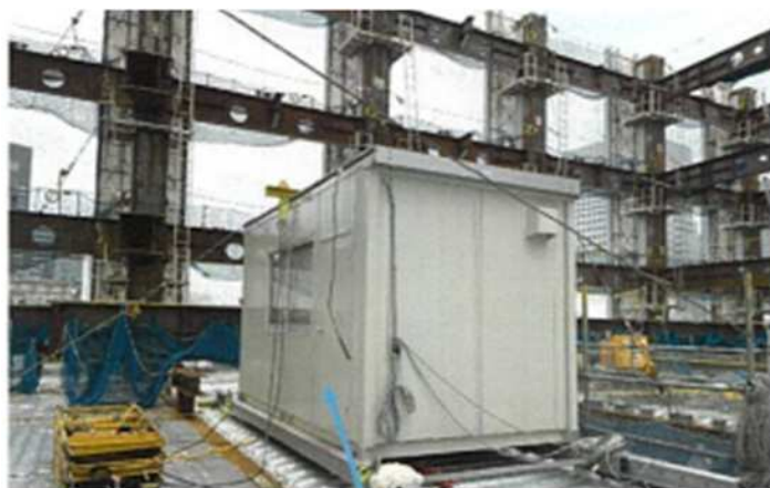
地上鉄骨施工階に休憩所設置 (エアコン、机椅子)
