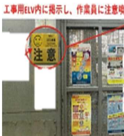
工事用エレベータに掲示
