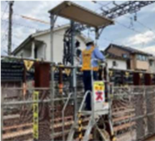
列車監視台屋根設置
