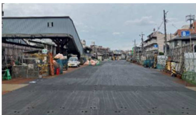
構台上を黒の塗料で塗る (輻射熱対策)
