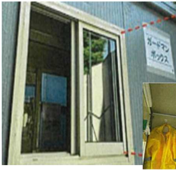
ガードマンボックス、エアコン設置
