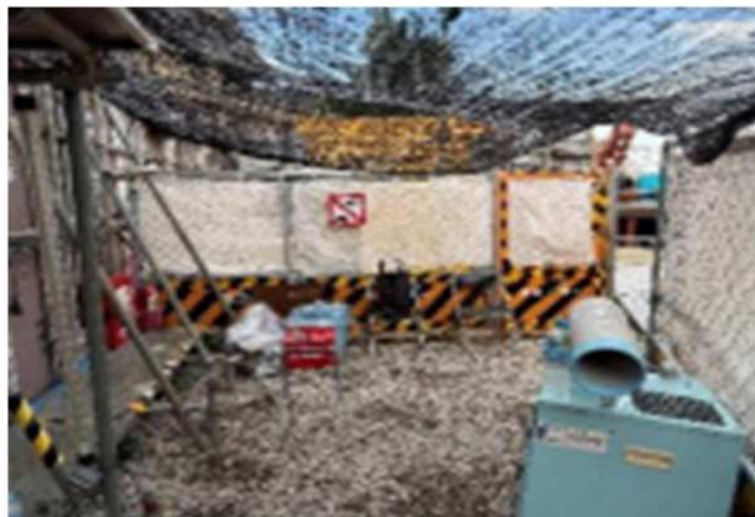
簡易休憩所設置
