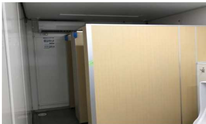
トイレにエアコン設置
