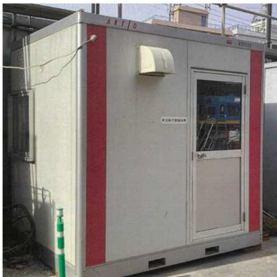
警備員用の専用ボックスを設置
