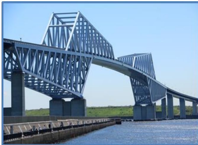
東京ゲートブリッジ
