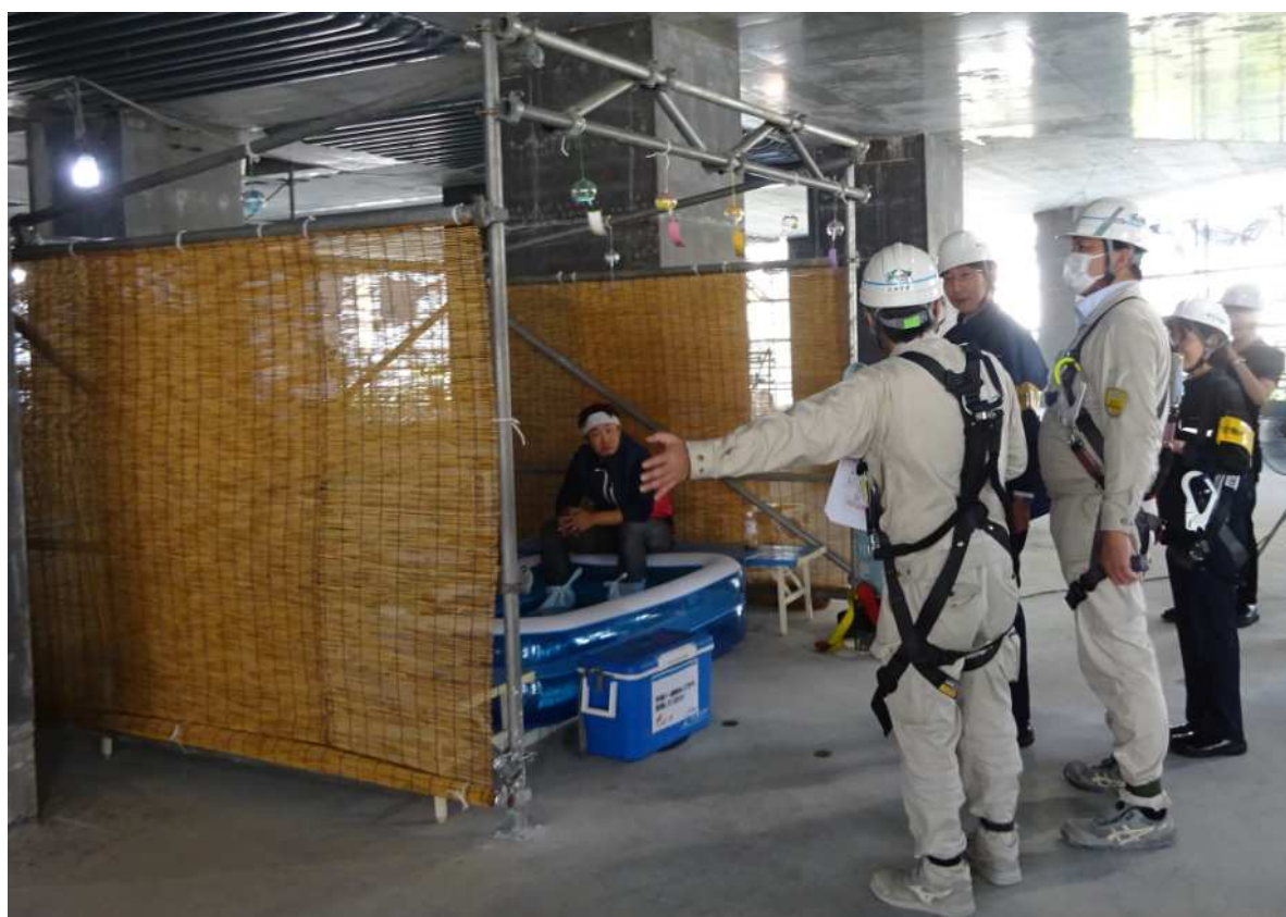
2階に設けているクーリングエリアの確認を行う岡田労働基準部長
