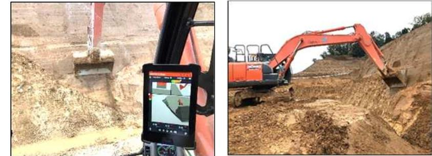
ICT重機を用いた掘削の様子
