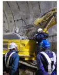
(3) 車両系機械を用いた測定
