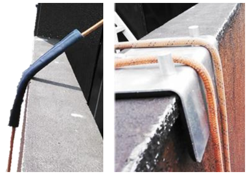
切断防止措置の例 (置き型養生) ▲
