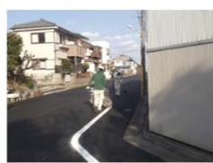
作業風景：（例）消えかえている標示を復活させます。手押しライナーで印に沿って白線を引いていきます。きれいに引くにために掃除もします。
