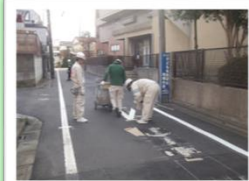
作業風景：（例）消えかえている標示を復活させます。手押しライナーで印に沿って白線を引いていきます。きれいに引くにために掃除もします。
