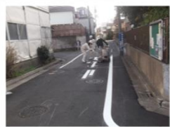
作業風景：（例）消えかえている標示を復活させます。手押しライナーで印に沿って白線を引いていきます。きれいに引くにために掃除もします。
