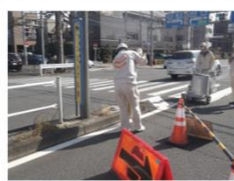
作業風景：（例）消えかえている標示を復活させます。手押しライナーで印に沿って白線を引いていきます。きれいに引くにために掃除もします。
