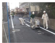
作業風景：（例）消えかえている標示を復活させます。手押しライナーで印に沿って白線を引いていきます。きれいに引くにために掃除もします。
