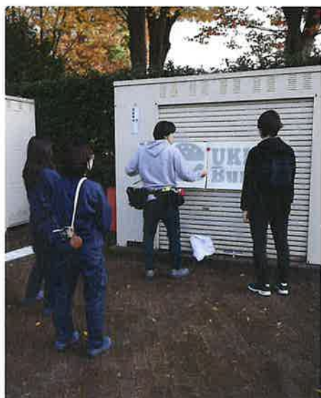
フィルム施工
