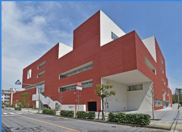
城東職業能力開発センター
