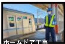
ホームドア工事
